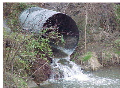
Regnvatten innehållande zink blandas ut med vatten från andra källor, vilket gör att zinkhalten sjunker ytterligare.
